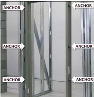
20. Instale un cabezal encima del marco. Los postes deben ser perpendiculares al canal de acero. La medida entre las jambas debe ser la misma en la parte superior e inferior del marco.
