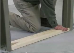
11. Coloque el marco alineado con el muro en la localización correspondiente.
