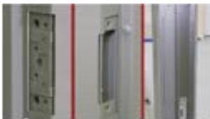
Como se muestra en la imagen inferior, estamos utilizando una bisagra de 4-1/2", una contrachapa ASA y refuerzos de cierrapuertas tanto para brazo regular como brazo paralelo. Los Anclajes de Alambrón pueden ser utilizados en diferentes tipos de muros de albañilería, y son los que serán utilizados en este ejemplo de instalación.
