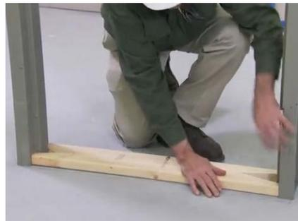
**PRECAUCIÓN:** Verifique que la barra separadora ha sido cortada con precisión y este encuadrada. Que así sea, ayudara a alinear las jambas mientras son ancladas al piso, lo cual es crítico para una correcta instalación.
